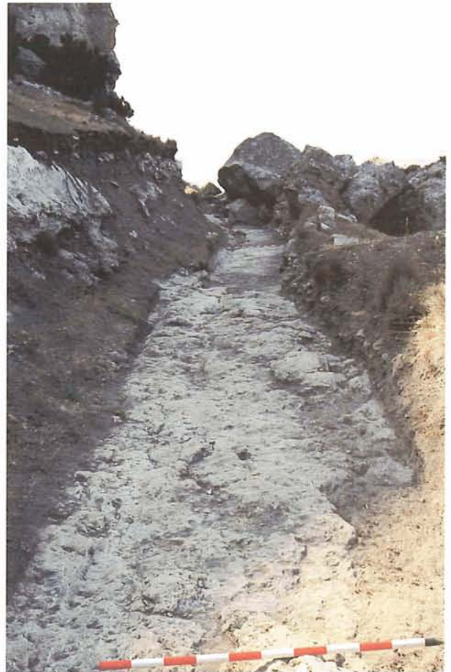
Lám. XXIX.—Vista general del Tramo 1.000-1.020 m.
