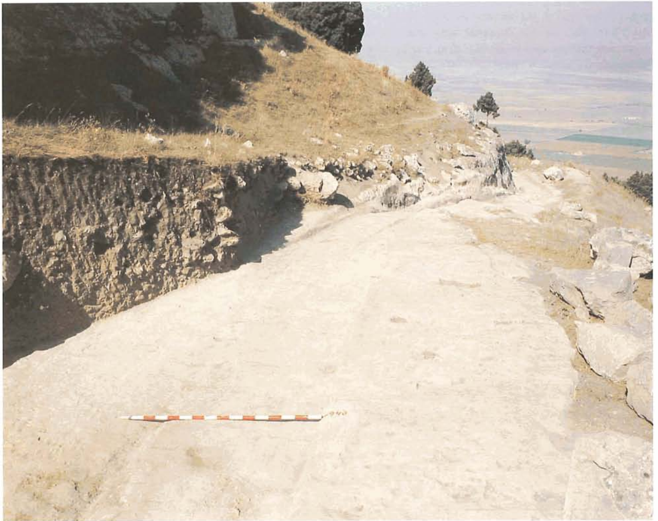
Lám. XXIV.—Vista general del Tramo 940-960 m.
