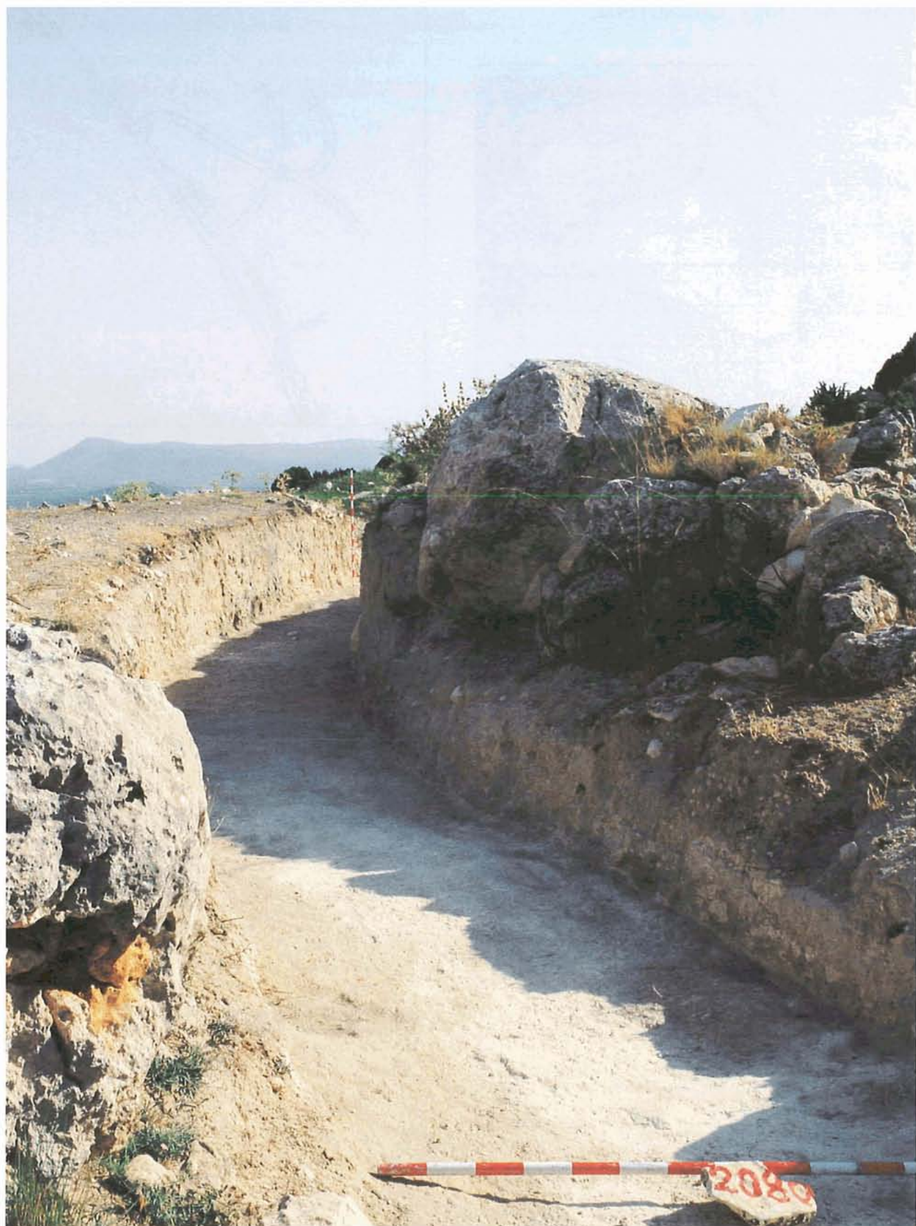
Lám. CXLII.—Vista del Tramo 2.080-2.100 m. Camino Final.
