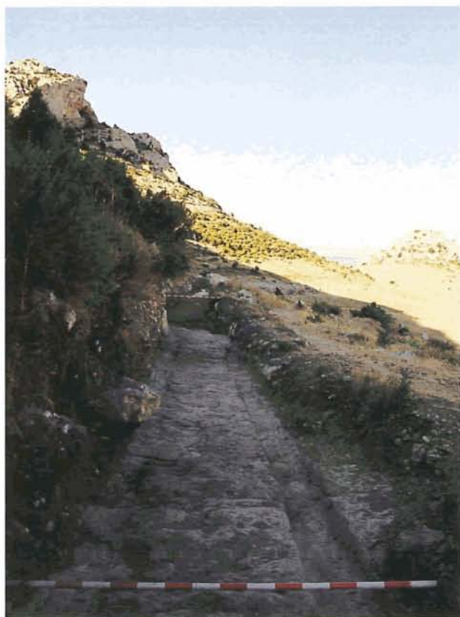
Lám. LXVII.—Vista general del Tramo 1.380-1.400 m.
