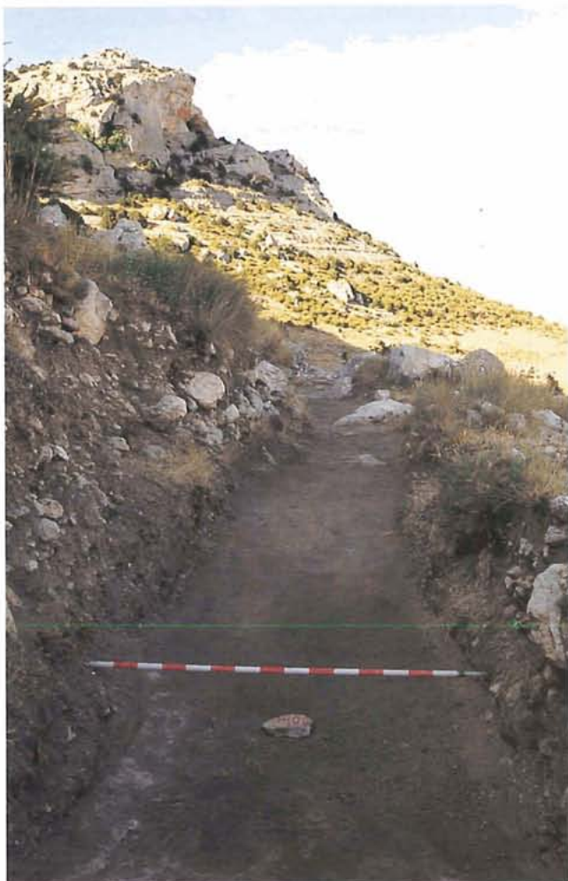
Lám. LXVIII.—Vista general del Tramo 1.400-1.420 m.
