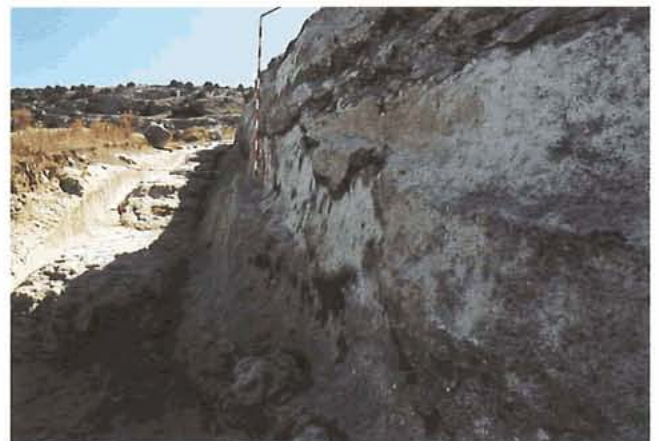
Lám. XXVII.—Primitivos niveles del camino.
