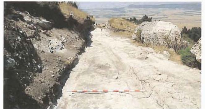
Lám. XLVII.—Vista general del Tramo 1.220-1.240 m.
