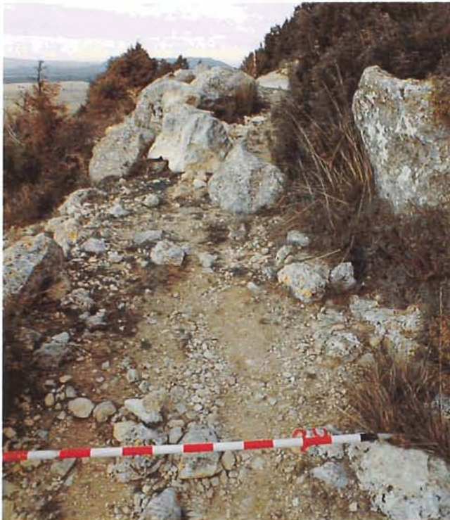
Lám. CLXXII.—Vista general del Tramo 20-40 m.
