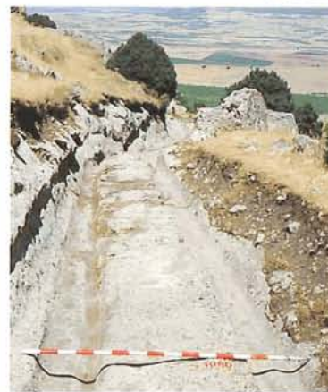
Lám. XXXVI.— Vista general del Tramo 1.080-1.100 m.
