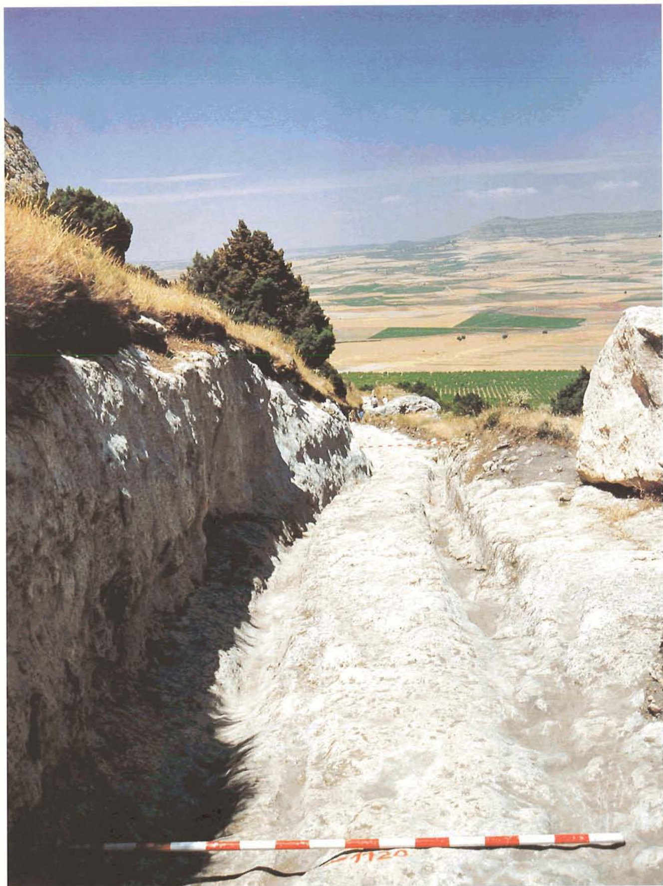
Lám. XXXIX.—Vista general del Tramo 1.120-1.140 m.
