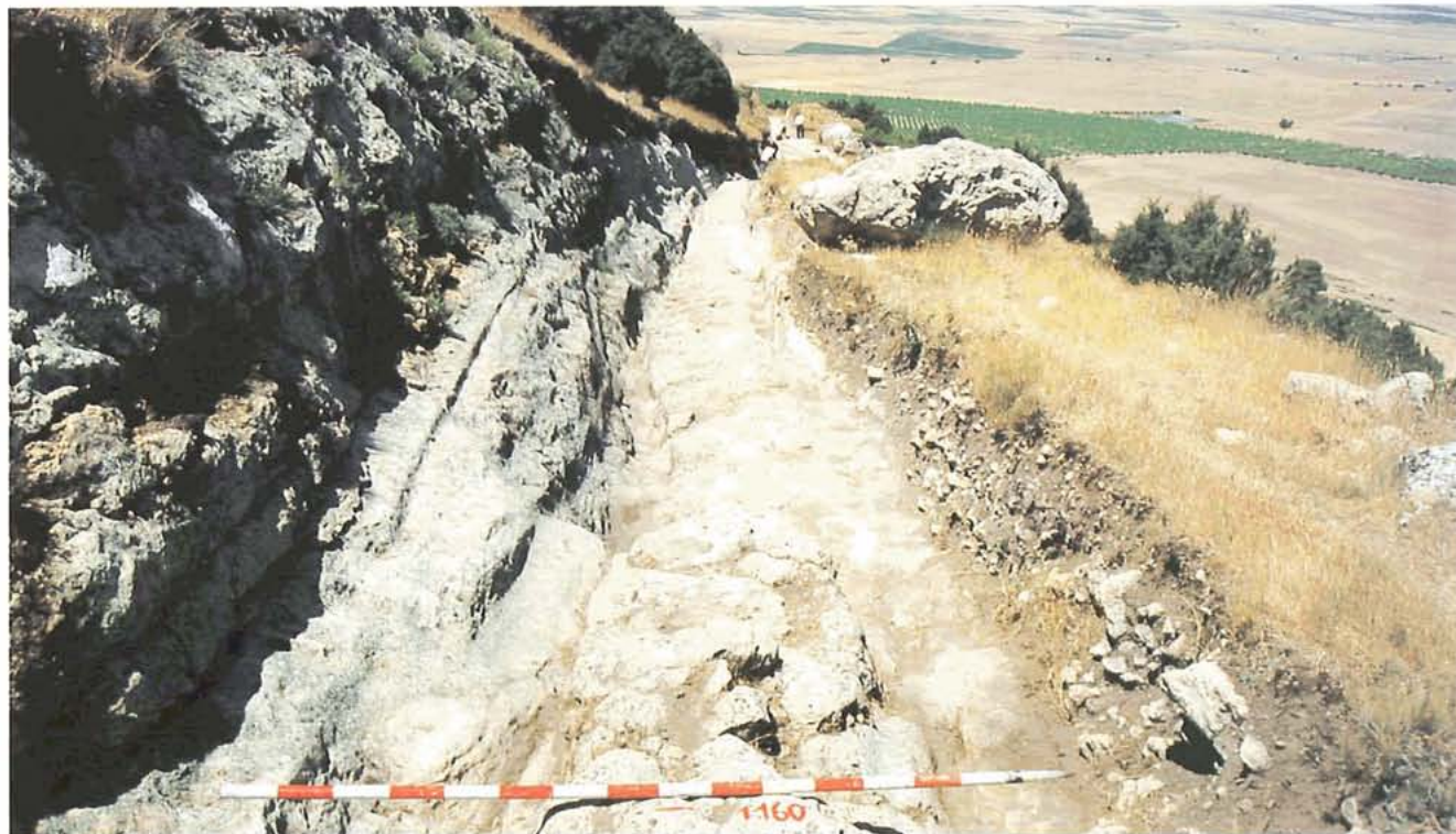
Lám. XLII.—Vista general del Tramo 1.160-1.180 m.
