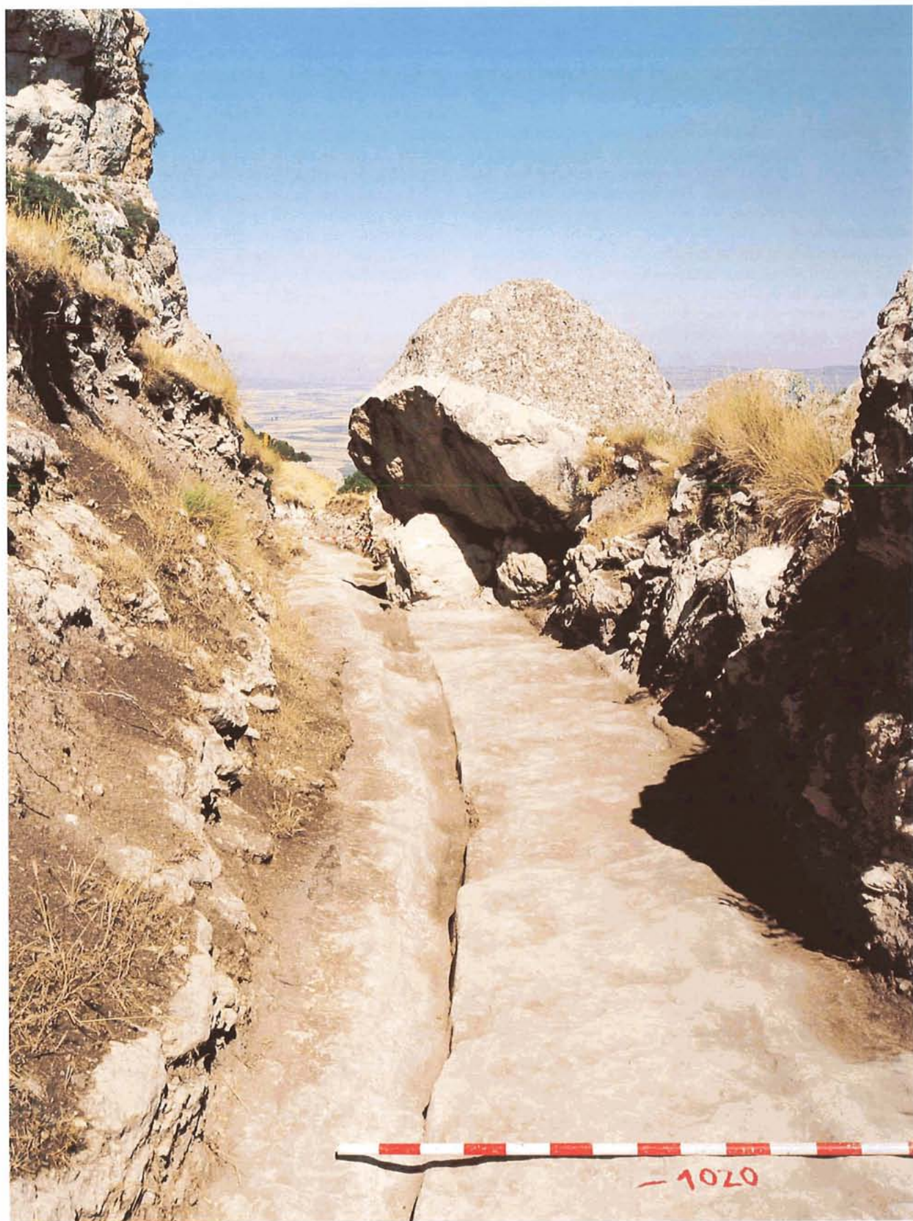
Lám. XXX.—Vista general del Tramo 1.020-1.040 m.
