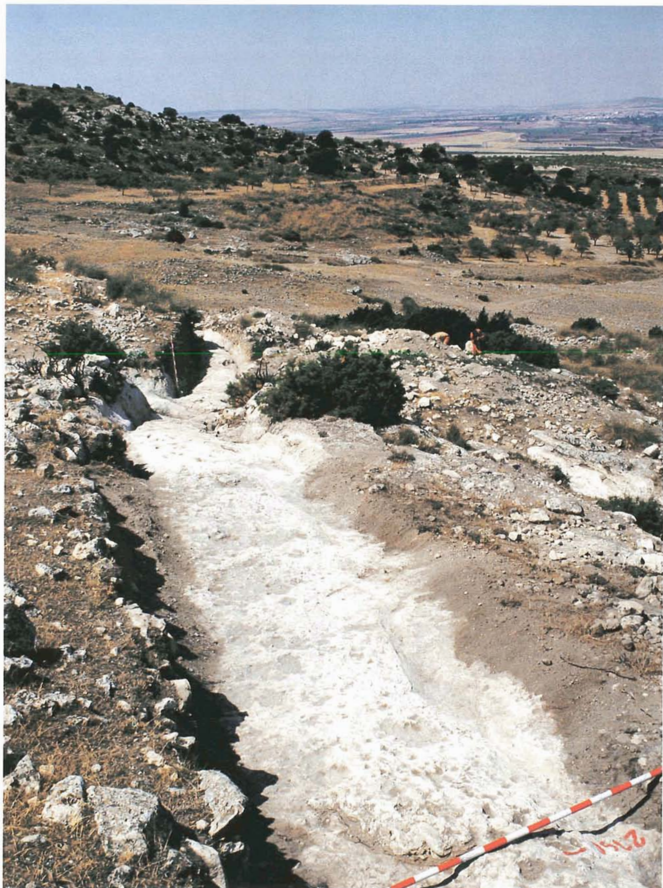
Lám. CLVI.—Vista general del Tramo 2.160-2.180 m.
