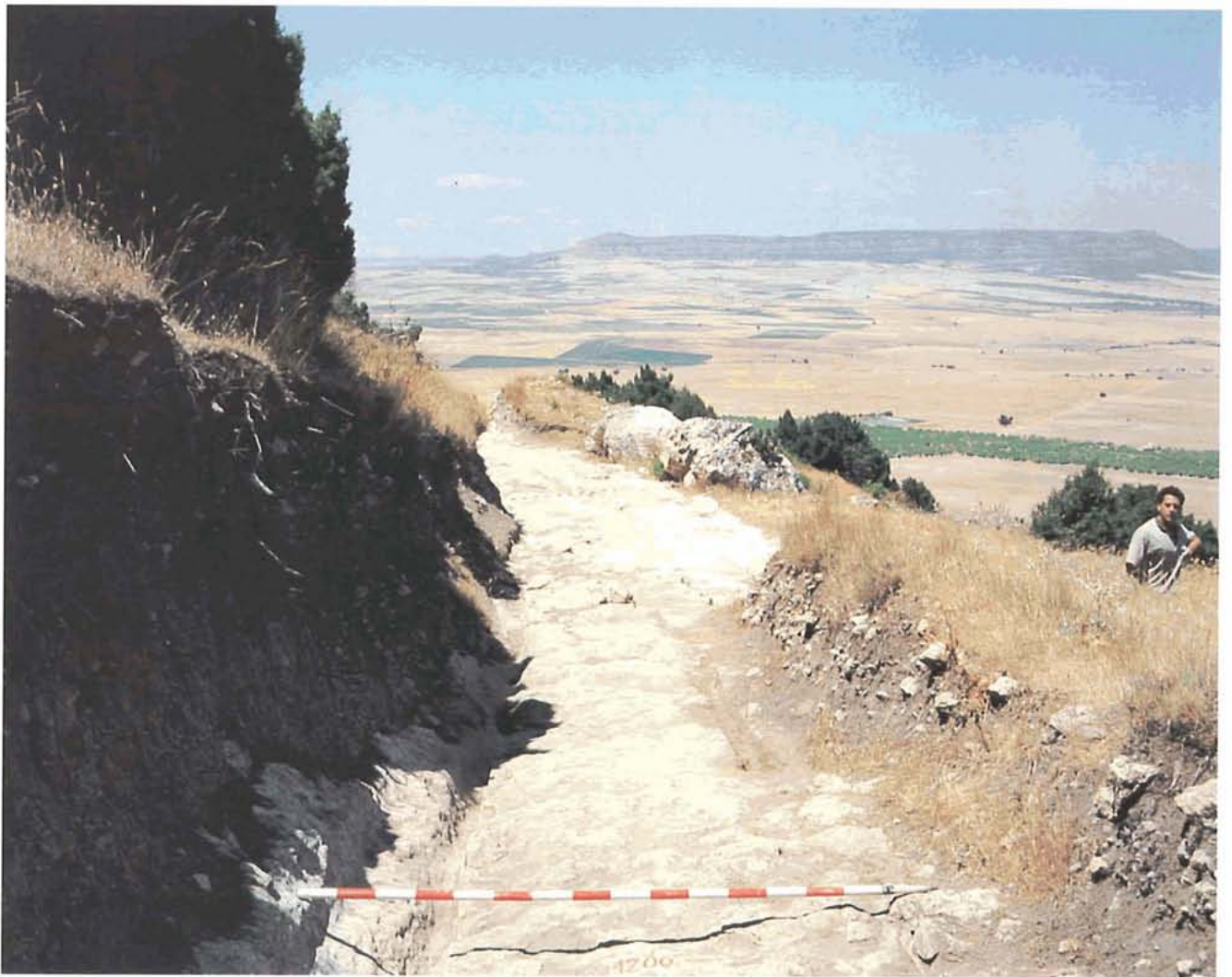
Lám. XLV.—Vista general del Tramo 1.200-1.220 m.
