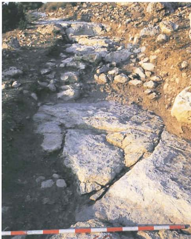
Lám. CC.—Vista general del Tramo 60-80 m.
