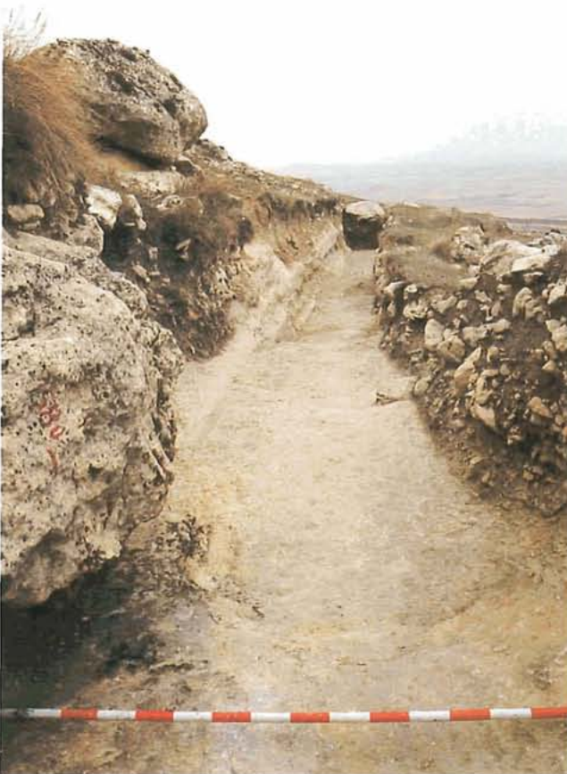
Lám. LXXXVII.—Vista general del Tramo 1.580-1.600 m.
