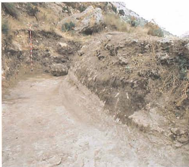
Lám. LXXIV.—Vista general del Tramo 1.460-1.480 m.
