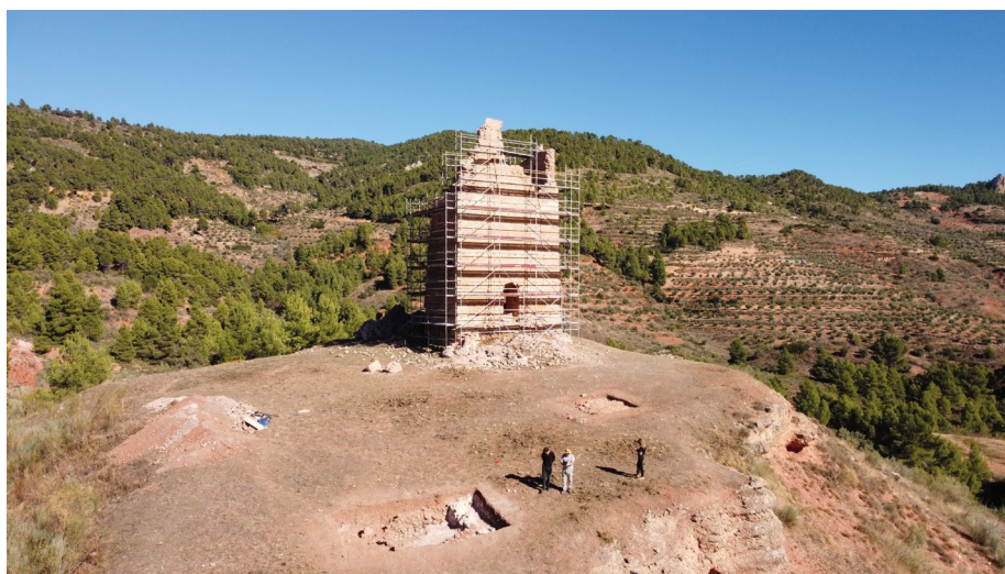
Figura 6. Fotografía aérea de las excavaciones en la Torre de Haches (2022). Elaboración propia.
