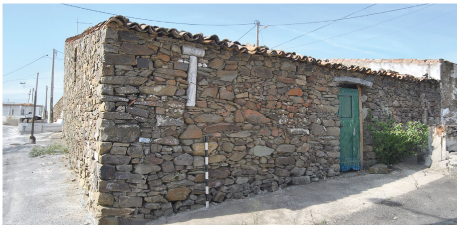
Figura 4. Dos fustes de columnas, reutilizadas en una pared de mampostería de piedra en el pueblo de Mesquita. Se puede leer en la columna horizontal la fecha de 1831, posiblemente la data de colocación en este lugar.
